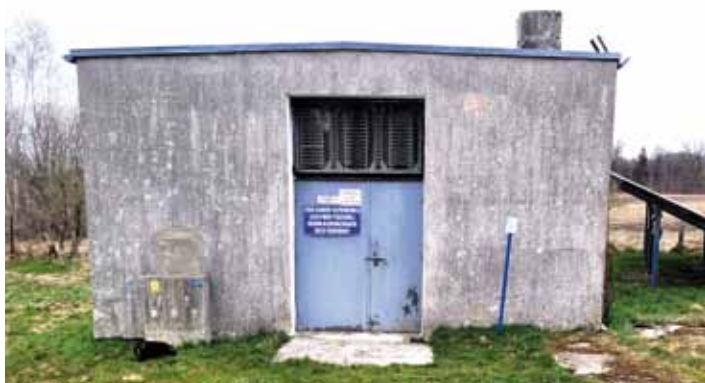
Aktualna fotografia stacji uzdatniania wody w Rówienku.
