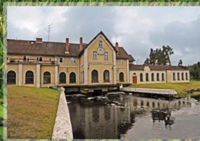
Elektrownia Wodna - Żelkowo
